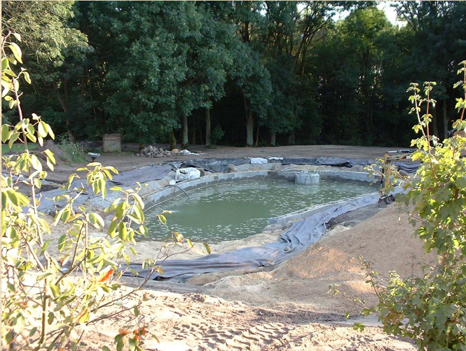
Bild 12 1. Füllen des Schwimmbereiches mit Wasser 05.09.02
