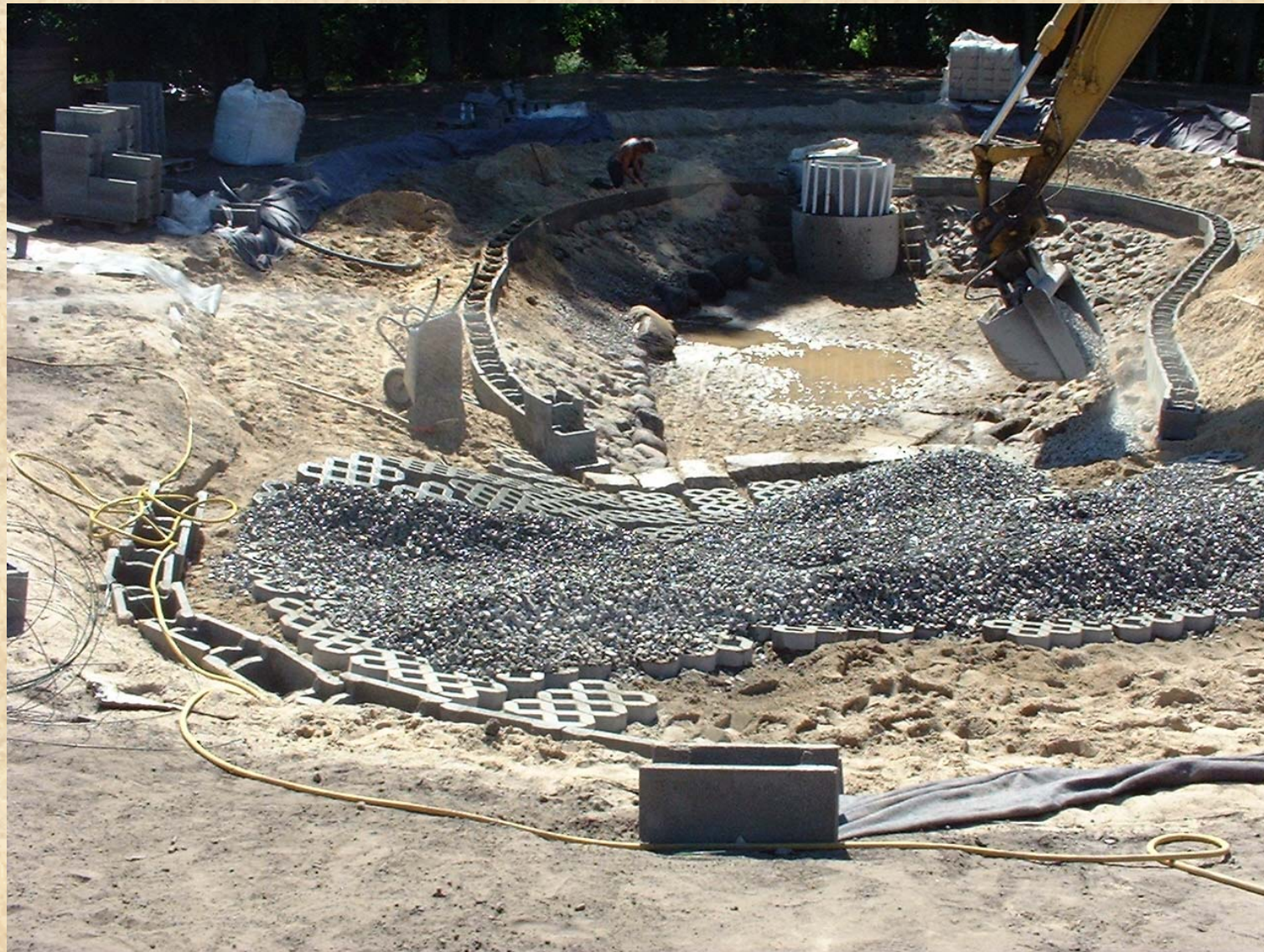
Bild 11 Befestigung des Flachwasserbereiches 02.09.02
