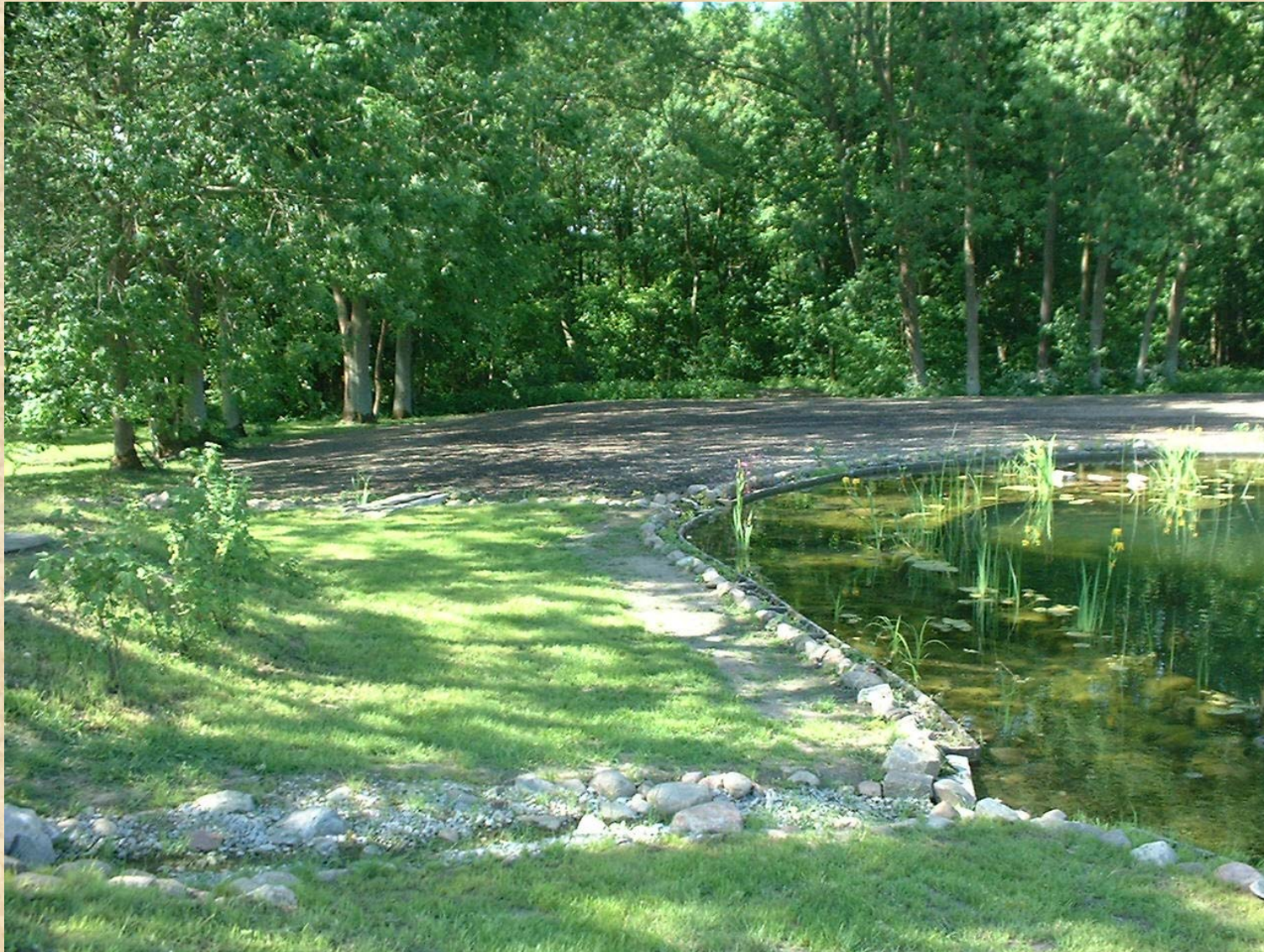
Bild 18 Zulauf (vorne) und Ablauf (hinten) 28.05.03
