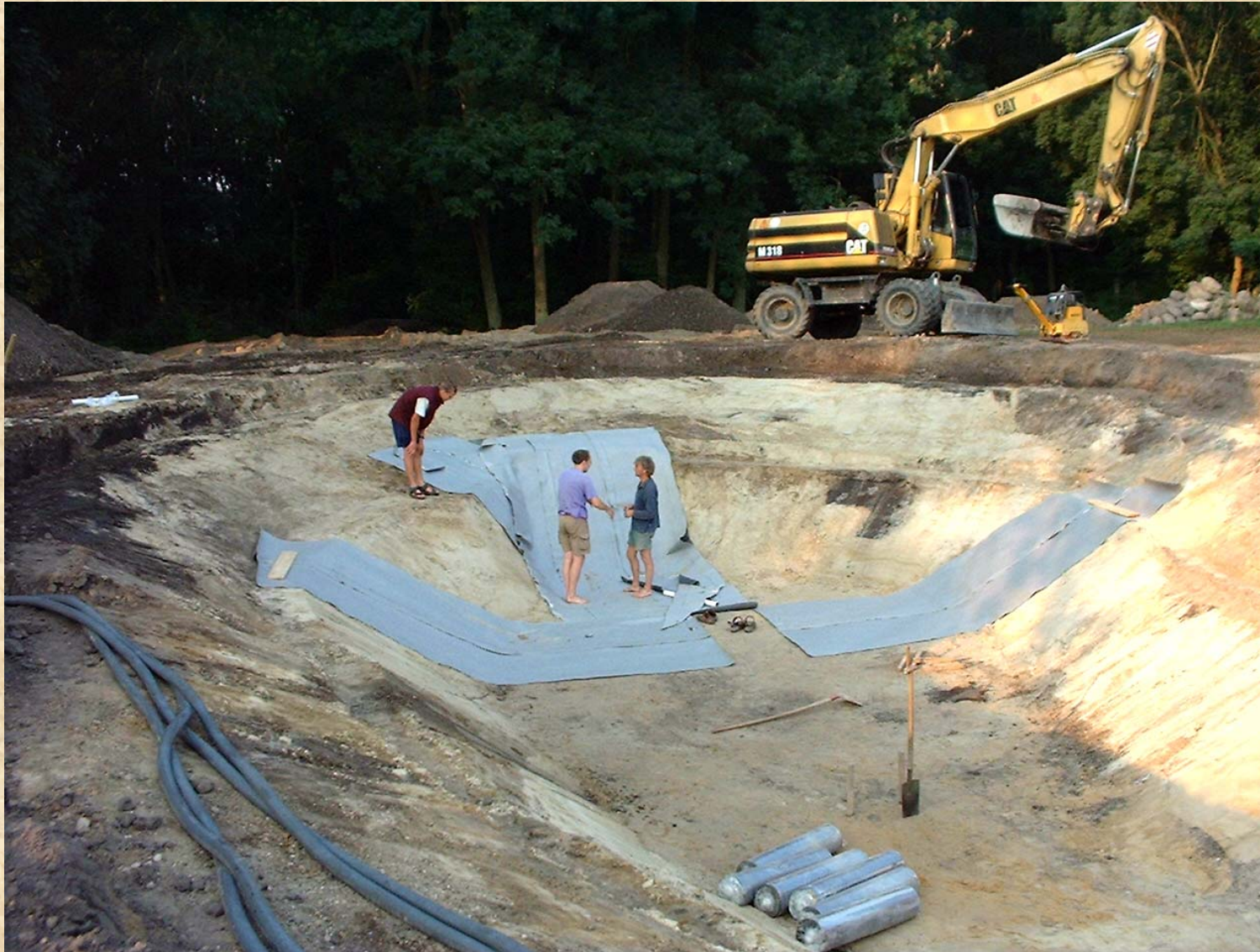
Bild 2 Verlegen der Tonabdichtung 27.08.02
