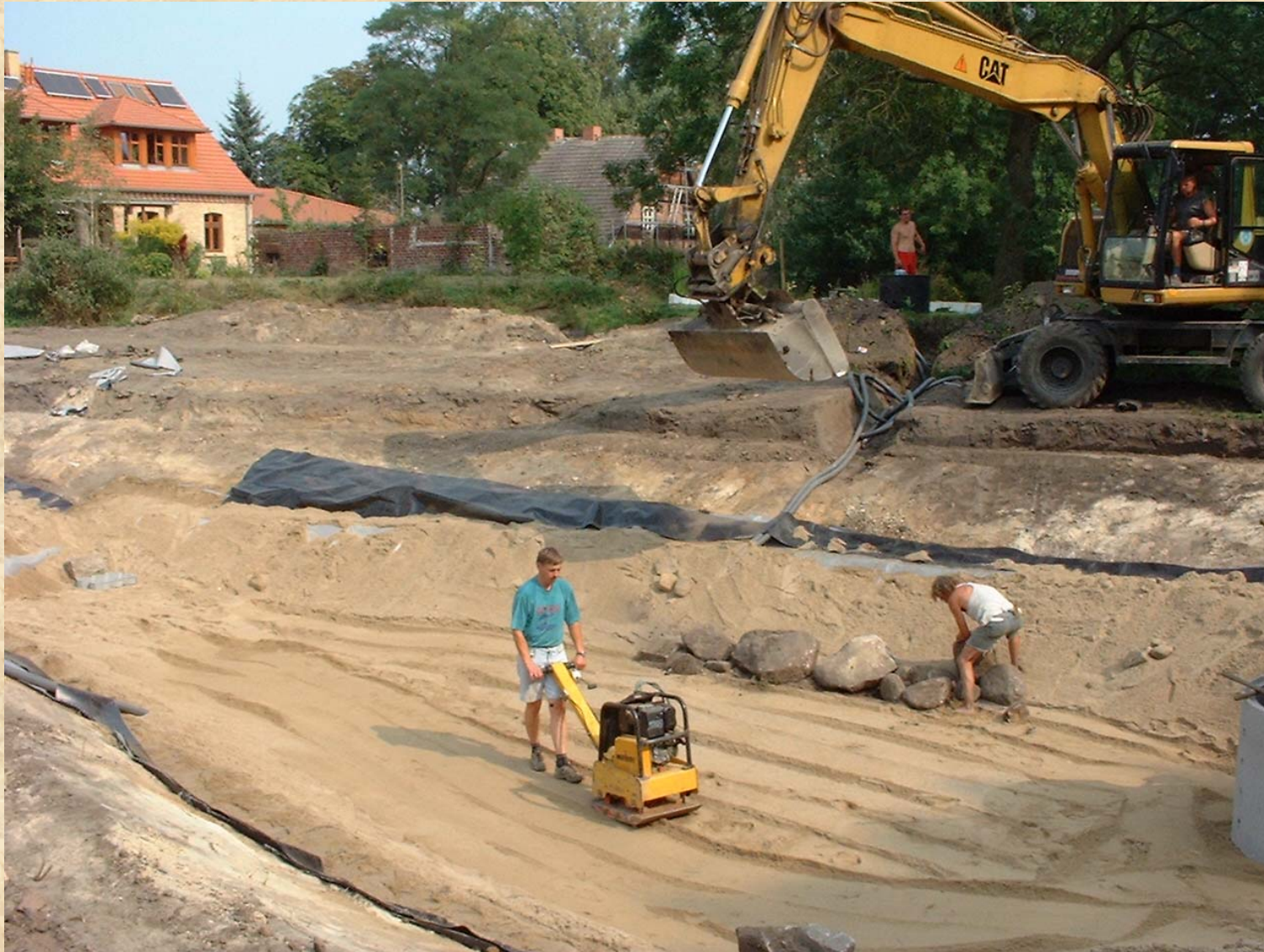
Bild 6 Verdichten der Kiesschicht 28.08.02
